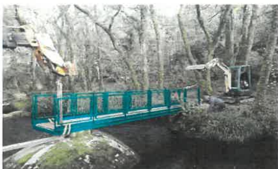
Ci-dessus en cours de montage.
